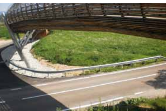
L'altezza tra la carreggiata stradale e l'intradosso dei sovrappassi pedonali non deve essere inferiore a 5 metri
