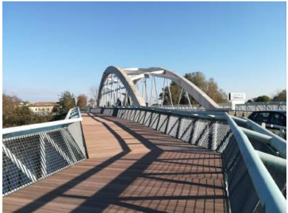
Figura 13 - SP42 passerella ciclopedonale sul fiume Piave
