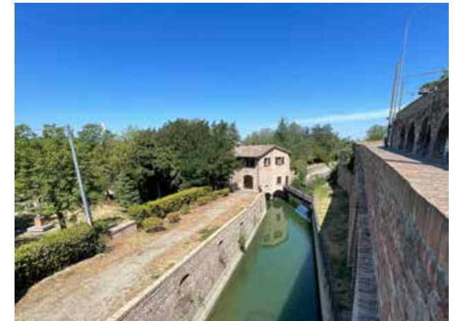
Picture Ice House spillways, Casalecchio di Reno, Bologna (Source: Itineraria)
