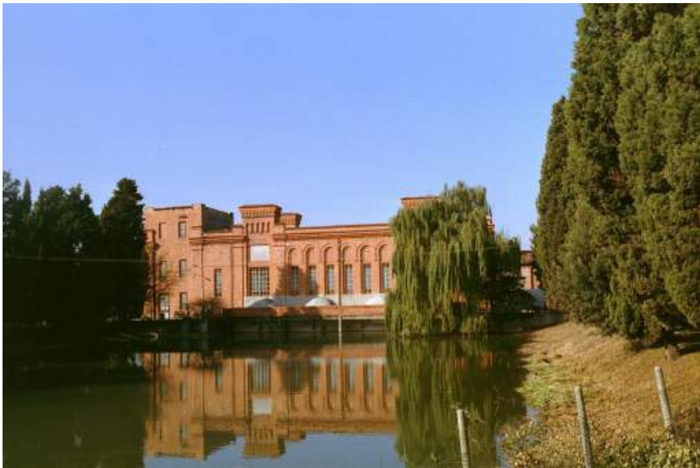
Idrovora del Termine
