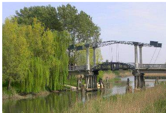
Ponte a bilanciere a Portegrandi
