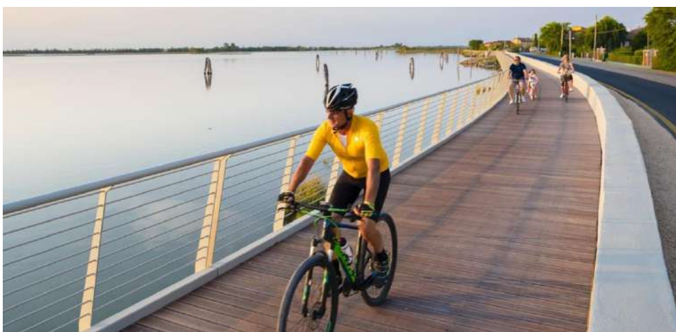
La pista ciclopedonale a sbalzo lungo il Canale Pordelio. Fonte: visitcavallino.com
