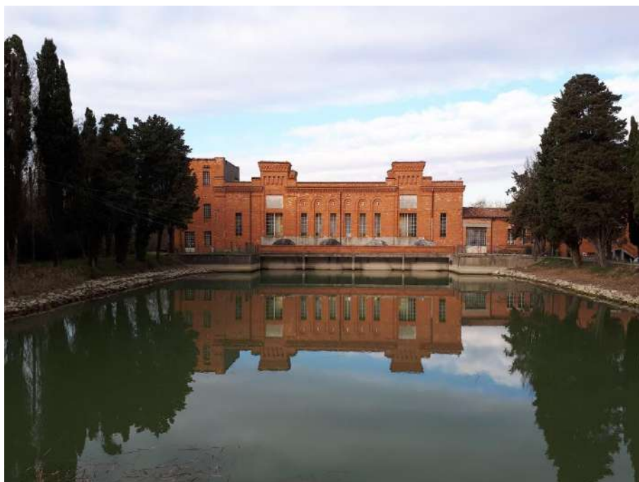
L'idrovora del Termine in Comune di Caorle. Fonte: terrevalute.it
