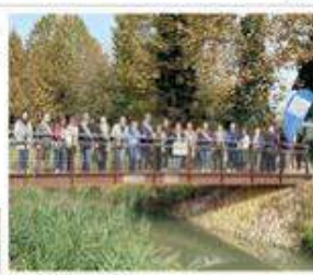
Le opere di restauro del Ponte di S. Maria e del Ponte di S. Andrea.
