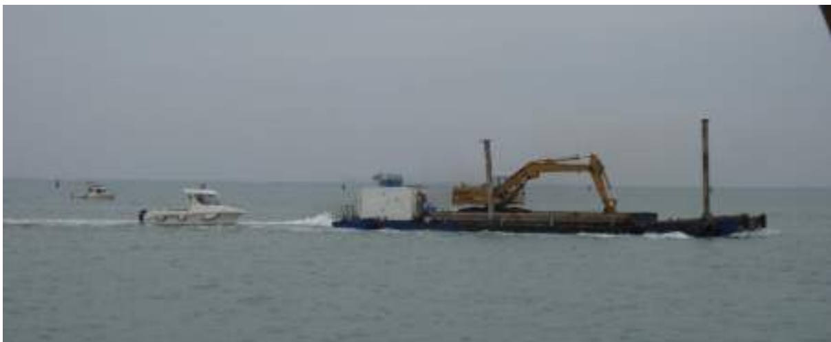
Pontone per l'esecuzione di interventi infrastrutturali in laguna di Venezia
