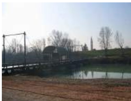
Ponte di Barche
