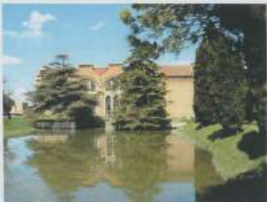
Impianto Idrovoro, Torre di Fine
