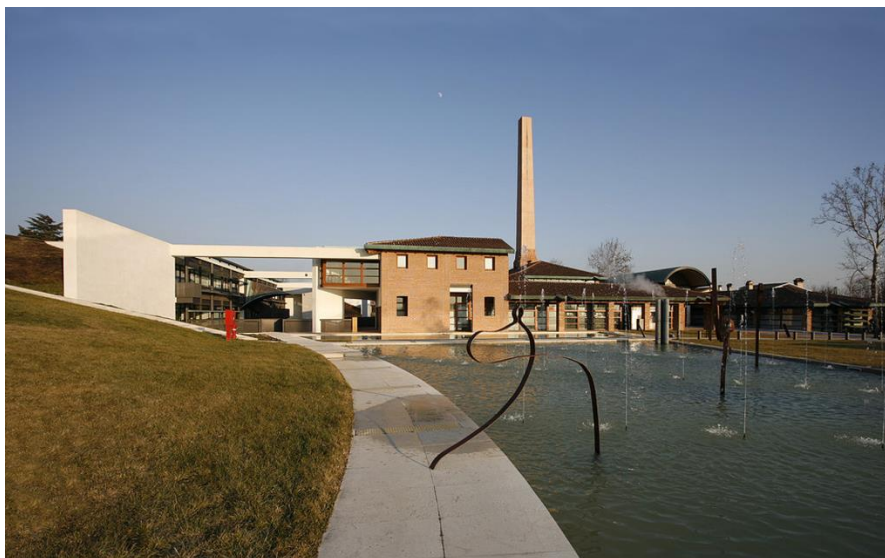
Spazi esterni della fornace di Asolo (TV)
