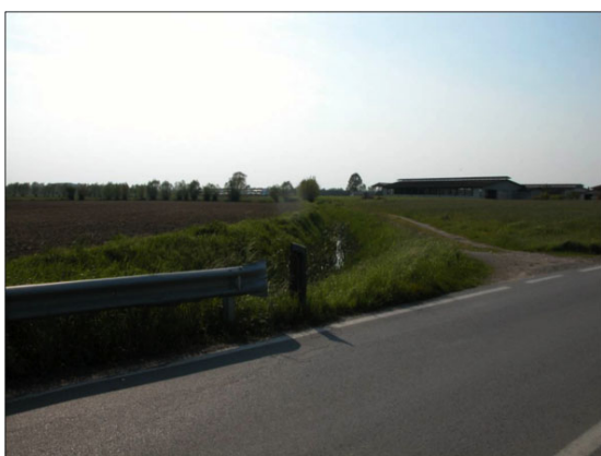
Attraversamento stradale di Via Molino (a valle)
