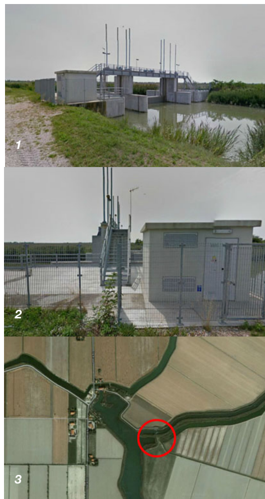
1 – Veduta del manufatto nei pressi del quale si ipotizza la realizzazione della passerella 2 – Veduta dell'accesso riservato 3 – Foto aerea e localizzazione
