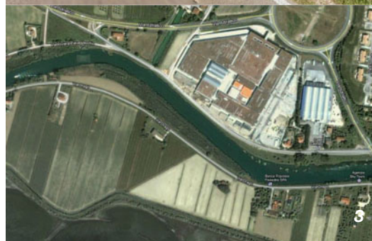
1 Veduta di via Drago in Comune di Jesolo 2 - Veduta della strada 3 - Foto aerea
